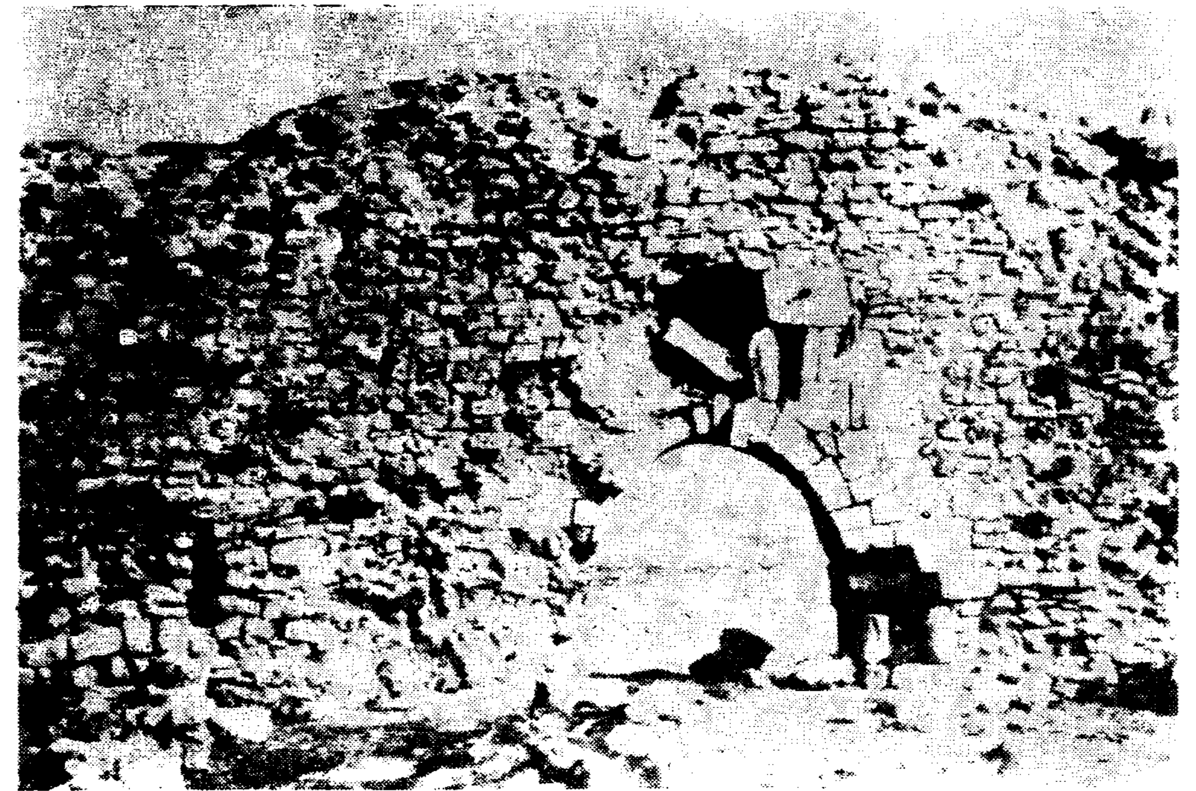
ش ۱۳- نمای داخلی دروازه شرقی
