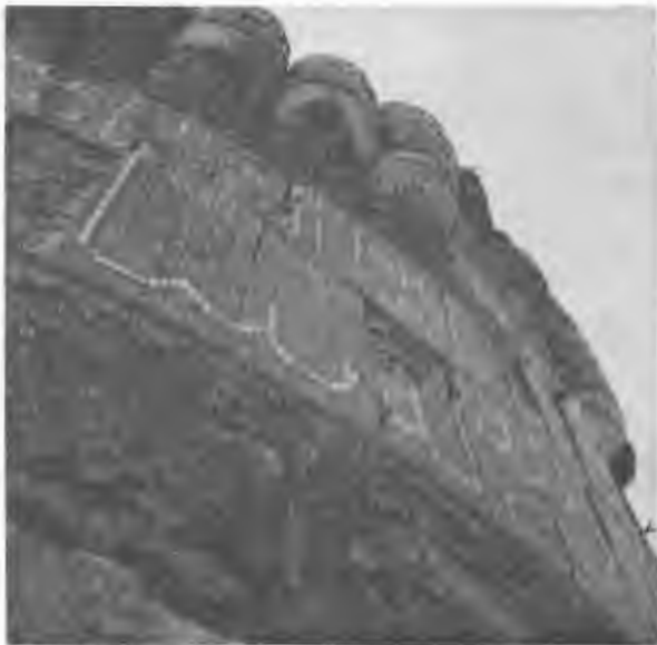
فهرست شماره ۵۹. بلخ: بقعه خواجه ابونصر، پارسا، جزئیات بین ساقه گنبد و پنجره مشبک ایوان - ساختمان طاق ایوان.
