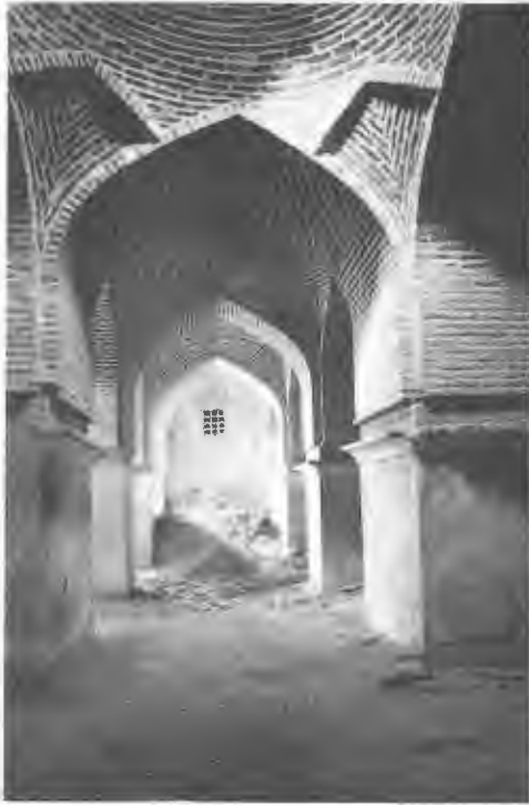
فهرست شماره ۱۰۲. نیشابور: مسجد جامع، کتیبه سنگی بتاریخ ۸۹۹ هجری نحوه طاق زنی نمازخانه کوچک، محراب مسجد.
