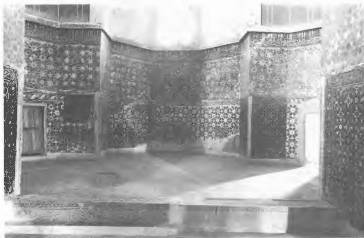
فهرست شماره ۷۵. هرات: زیارت‌گاه عبدالله بن معاویه، طاق‌بندهای پیش‌آمده زیر گنبد، ازاره‌های چندضلعی اطاق گنبد.
