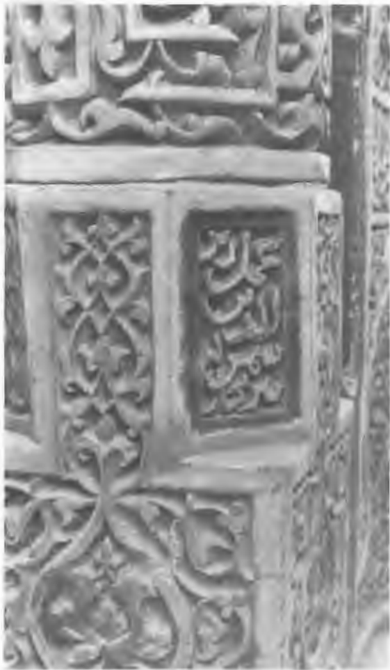
فهرست شماره ۱۴. سمرقند: آرامگاه شادی ملک آقا امضاء استاد کار بنا بر روی پایه ستون
