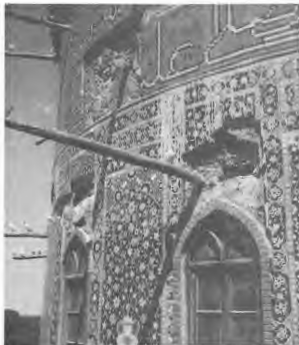
فهرست شماره ۵۹. بلخ: بقعه خواجه ابونصر، پارسا، جزئیات بین ساقه گنبد و پنجره مشبک ایوان - ساختمان طاق ایوان.
