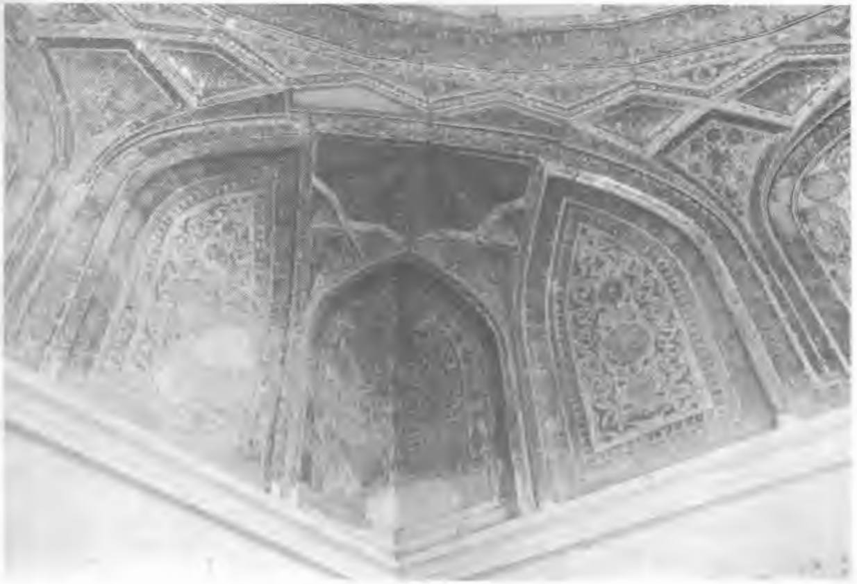
فهرست شماره ۷۲. هرات (گازرگاه) زرنگارخانه، سه کنج اطاق جنوبی با طاق کوکبی گچی - نقاشی گنبد خانه مرکزی.
