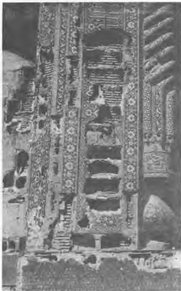
فهرست شماره ۵۹. بلخ: بقعه خواجه ابونصر، پارسا، جزئیات بین ساقه گنبد و پنجره مشبک ایوان - ساختمان طاق ایوان.
