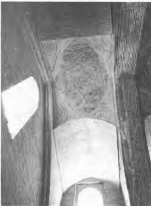
فهرست شماره ۱۶۷. اصفهان: مسجد جامع، صفة عمر، روزنه طاق (نورگیر) با کاربندی - طاق توپزه سه بخشی متقاطع - جزئیات کاشیکاری سر در شمالی (ویران شده)
