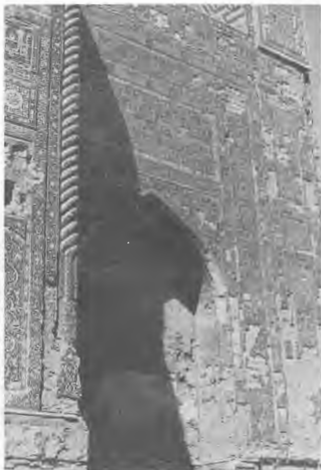
فهرست شماره ۳۹. شهرسبز: کاخ آق‌سرای. سردر ورودی بنا از جلو و عقب ساختمان.
