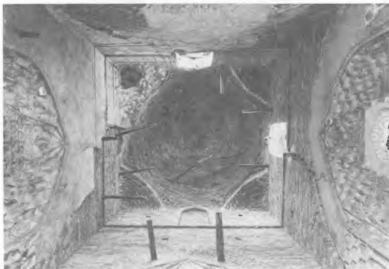
فهرست شماره ۴۰. شهرسبز: دارالسیاده، آرامگاه جهانگیر، سرداب شبستان سه کنج پوشیده با مقرنس های گچی
