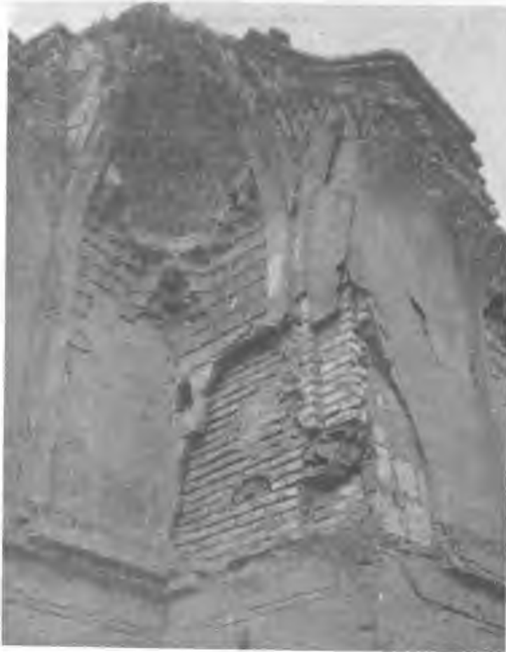
فهرست شماره ۳۵. سمرقند: مقبره عشرت‌خانه، جزئیات سردر ورودی - نحوه احداث طاق بنا
