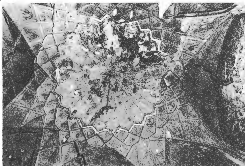
فهرست شماره ۸۹. لنگر: مقبره قاسم انوار، نمای عمومی مقبره، قوس‌های متقاطع مرکزی گنبدخانه - طاق کوكبي شاه‌نشين مقبره
