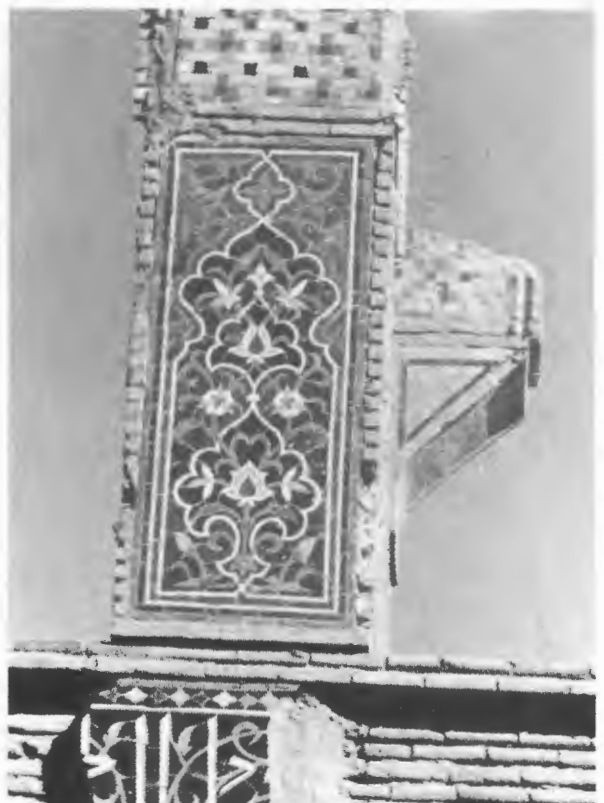
فهرست شماره ۱۶۷. اصفهان: مسجد جامع، صفة عمر، روزنه طاق (نورگیر) با کاربندی - طاق توپزه سه بخشی متقاطع - جزئیات کاشیکاری سر در شمالی (ویران شده)
