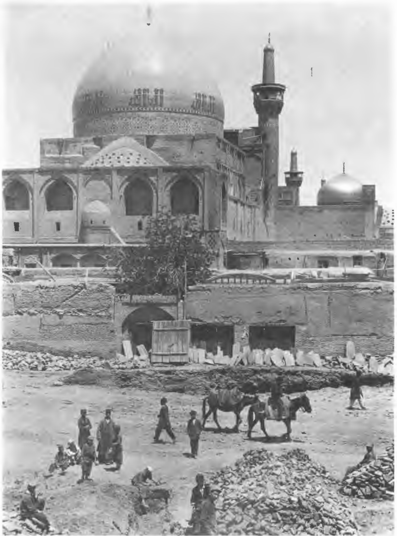
فهرست شماره ۹۰. مشهد: حرم حضرت رضا، نمای خارجی، جزئیات نحوه احداث و قرار گرفتن گنبد و نیم گنبد (از مجموعه انجمن ملی
