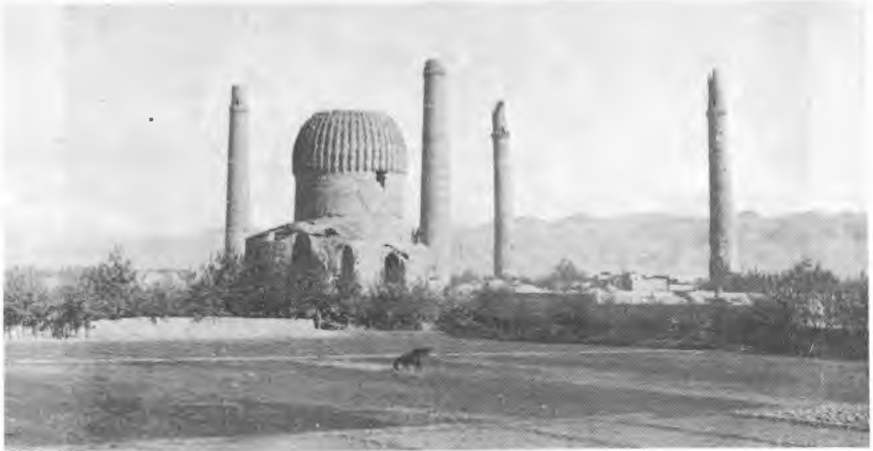
فهرست شماره ۷۷. هرات: مدرسه سلطان حسین بایقرا، بقایای چهارمناره تنها معرف بناست. مدرسه گوهرشاد در طرف چپ تصویر.
