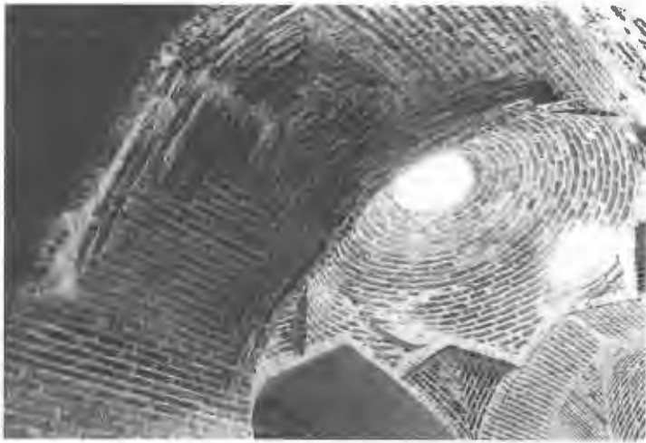
فهرست شماره ۱۰۲. نیشابور: مسجد جامع، کتیبه سنگی بتاریخ ۸۹۹ هجری نحوه طاق زنی نمازخانه کوچک، محراب مسجد.
