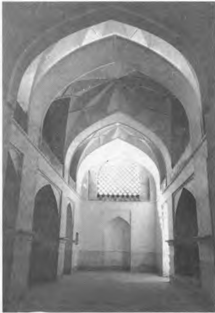
فهرست شماره A۲۲۶ یزد: مسجد میرچخماق، نمازخانه، با تویزه‌ها و طاق کوبی
